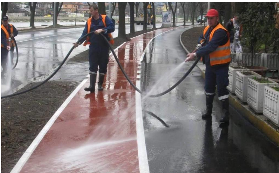
Slika 5. Završni radovi na biciklističkoj stazi
