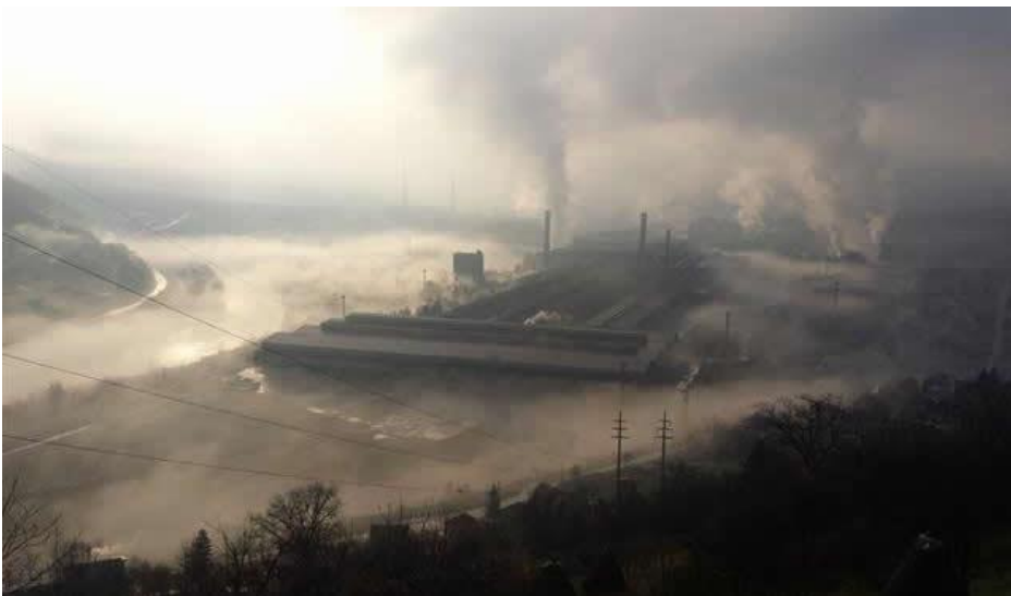
Slika 6. Pogled na tvornicu AMZ
