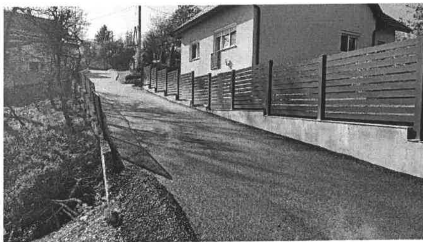
Slika broj 19: Sanacija i asfaltiranje ceste za zaseok Totići
