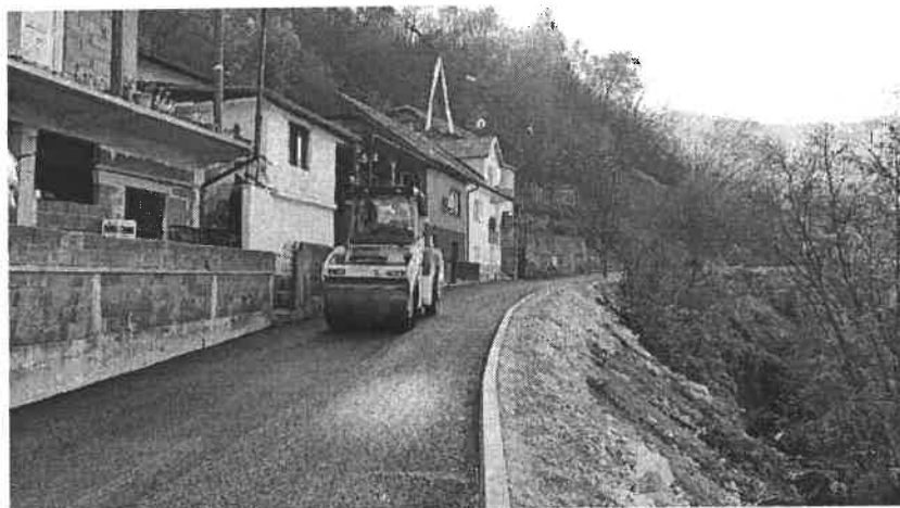
Slika broj 25: Sanacija i asfaltiranje dionice ceste za naselje Vardište
