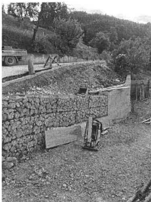
Slika broj 11: Sanacija dijela saobraćajnice na putu za Vražale sa izgradnjom potpornog zida
