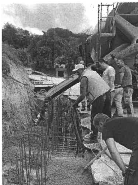
Slika broj 9: Sanacija klizišta na cesti za Vražale na mjestu gdje se nalazi lokalno mezarje
