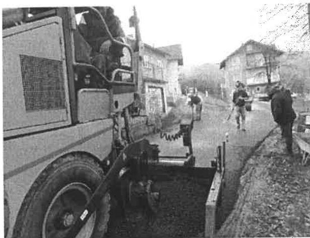
Slika broj 5: Sanacija i asfaltiranje ceste u naselju Crnile
