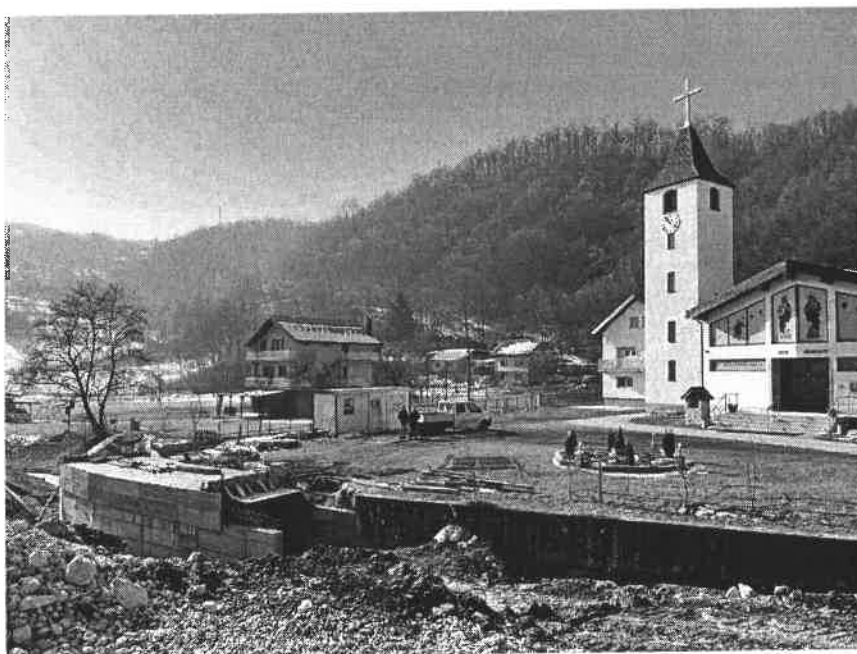
Slika broj 6: Izrada sandučastog propusta preko Čajdraškog potoka i priključne saobraćajnice
