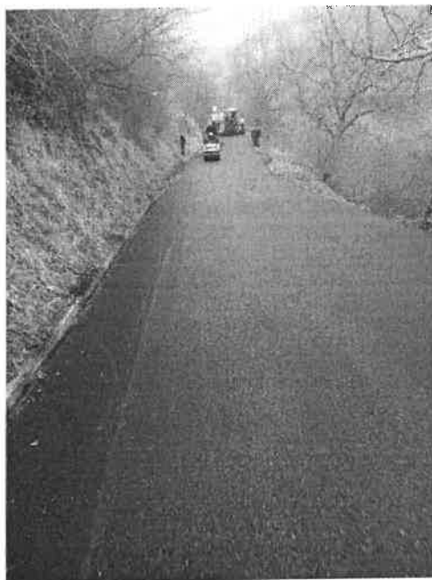
Slika broj 24: Presvlačenje betonske ceste asfaltom u selu Zahići
