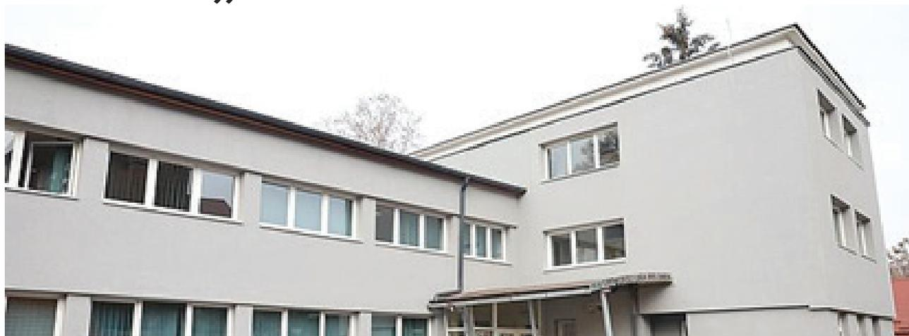
Završeni su radovi na utopljanju objekta Javne ustanove „Centar za socijalni rad Zenica“. Radovi su obuhvatili provođenje mjera energetske efikasnosti definisanih energetske auditom i to zamjenu krova, ugradnju novih gromobrskih instalacija, ter-
