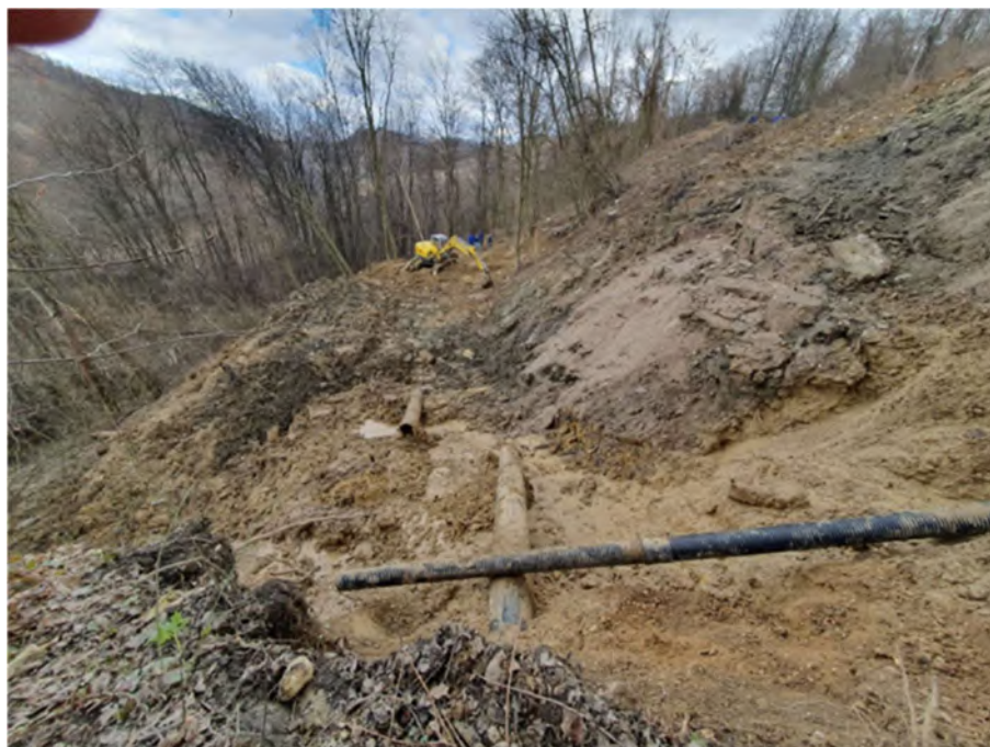
Slika broj 5: Kvar na magistralnom cjevovodu Kruščica – Zenica
